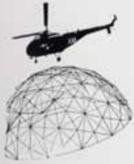
Fulcr & Eames. Helicóptero con cúpula geodésica de aluminio/Fulcr & Eames. Helicopter with aluminum geodesic dome
