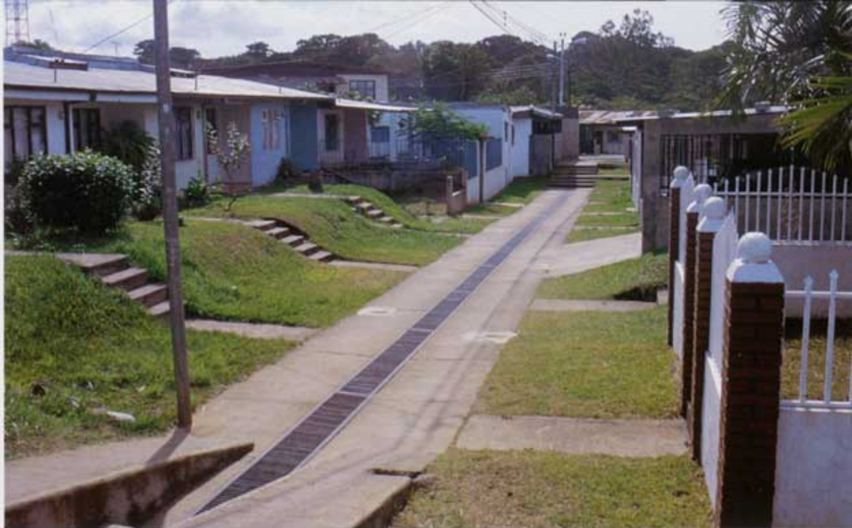
6. Barrio de vivienda social en Barreal, en la periferia de San José, construido y mantenido por medio de la autogestión comunal. Low-income housing in Barreal, on the outskirts of San José. Built and maintained through community self-management.
