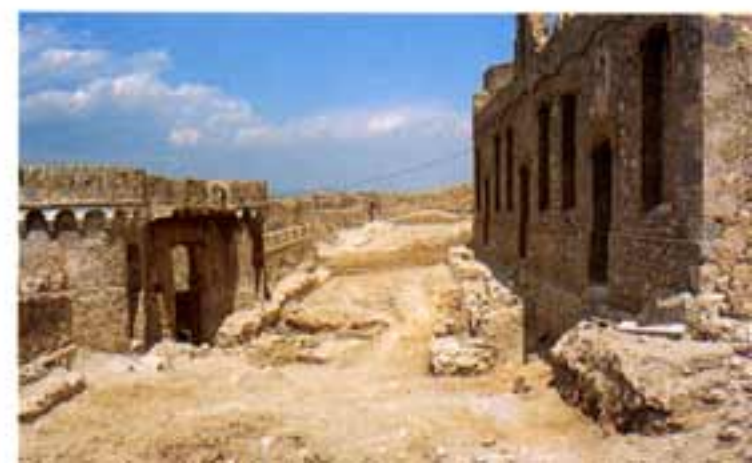
Estado del acceso interior al Castillo después de la excavación arqueológica State of the inner entrance to the Castle after the archaeological excavation
