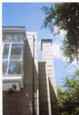
Vista de la chimenea Chimney view
