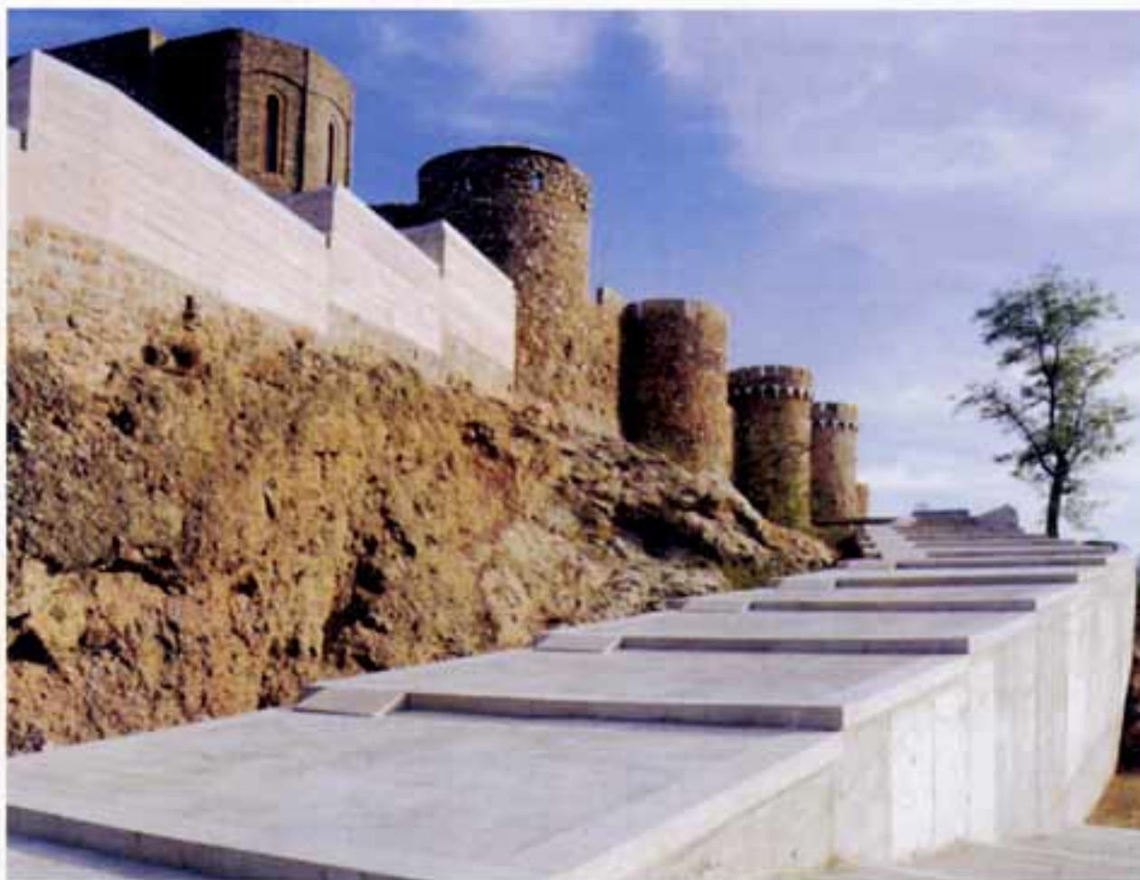
Vista de la escalera rampante del acceso View of the stepped access ramp
