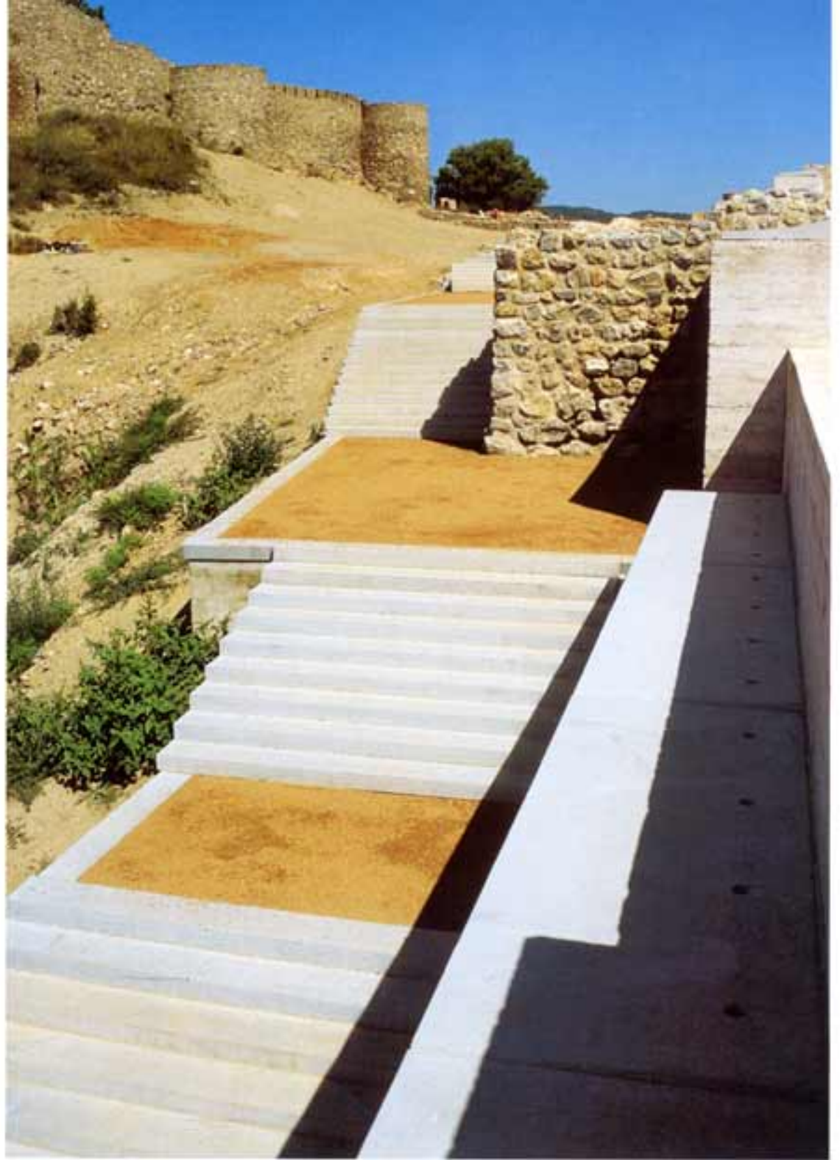
Tratamiento del paseo y paso de ronda Treatment of the footpath and wall top wall
