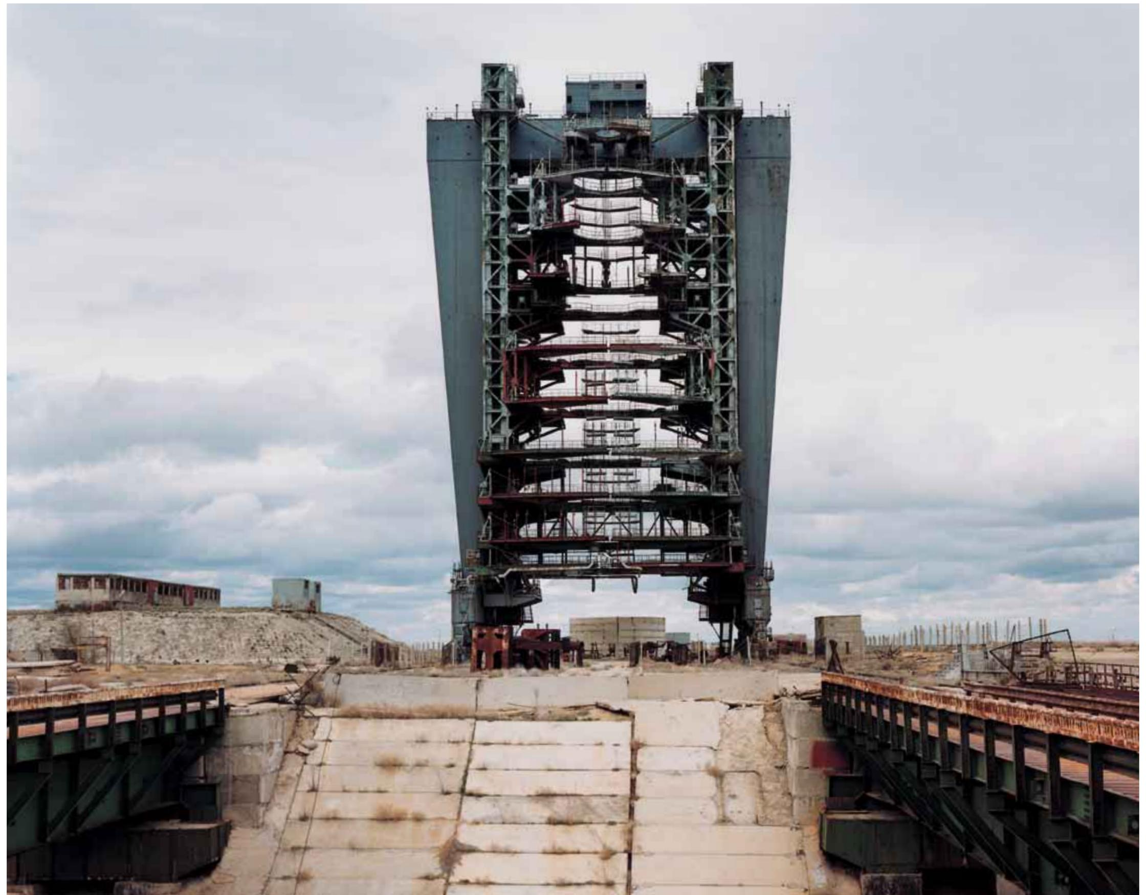
L'immensa 'buca' situata a fianco della rampa, progettata per assorbire il terribile calore e la luce accecante che si producono al momento del lancio. Costruita in pannelli di cemento, la magnifica struttura è ora in totale abbandono: lentamente si trasforma in una specie di lago artificiale in mezzo alla steppa del Kazakistan
