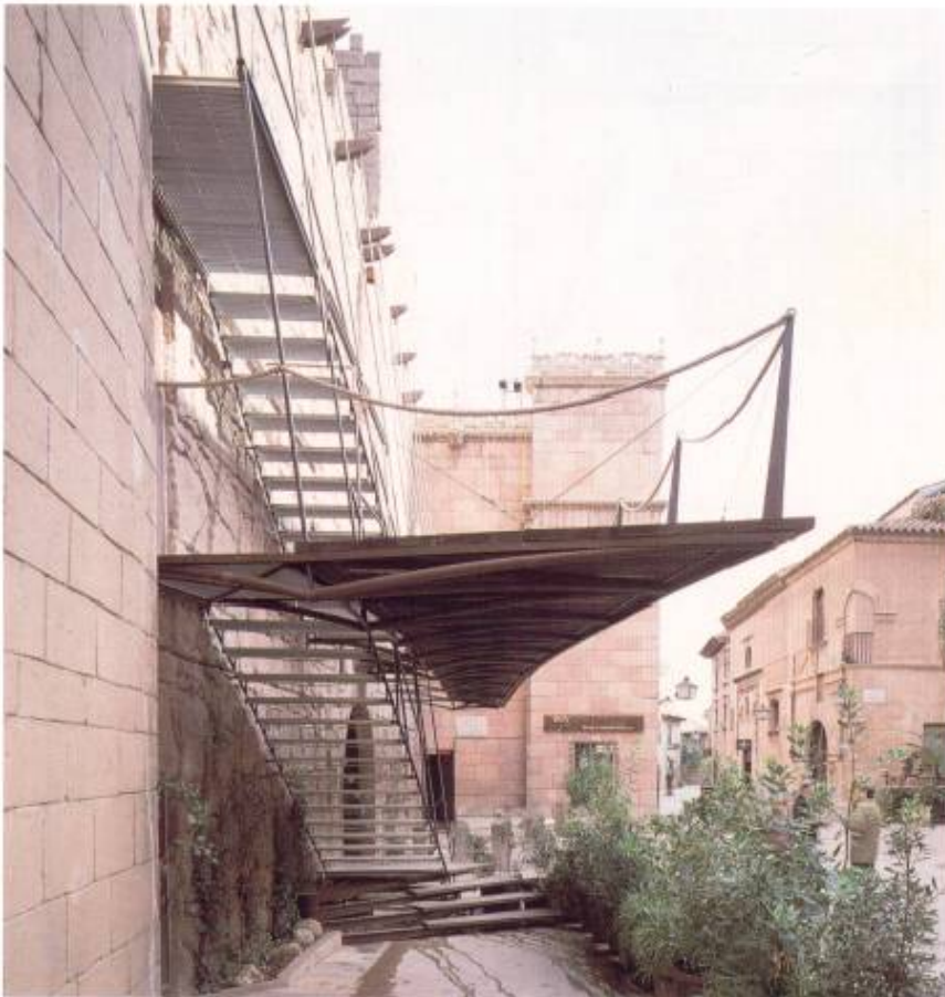
Escalera y pasarela exterior. Detalle del anclaje y cables de suspensión Outside gangway and staircase. Detail of anchoring and suspension cables
