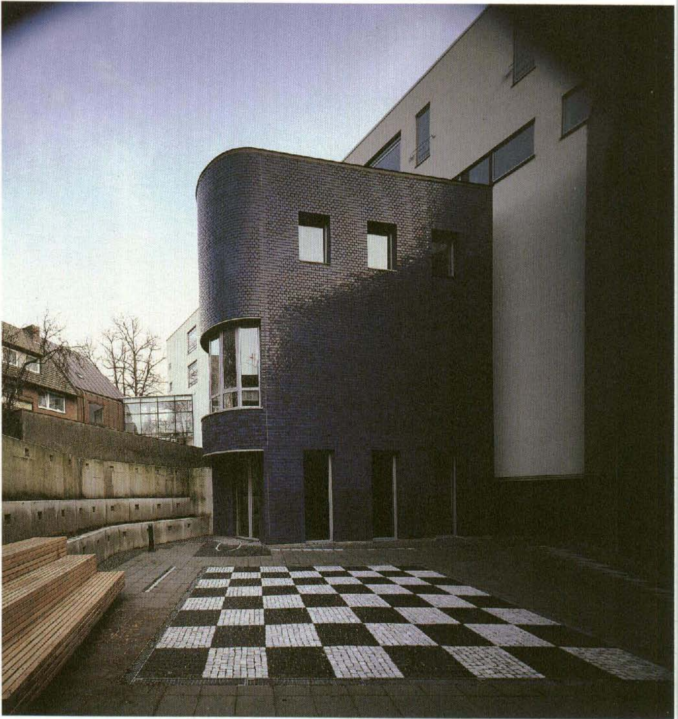
detalle de uno de los cuerpos triangulares de la fachada Norte / detail of one of the triangle wings on North facade
