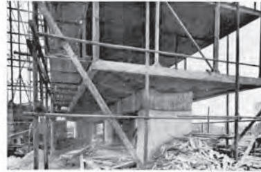
Les poteaux descendant à 19,50 mètres dans le sol
