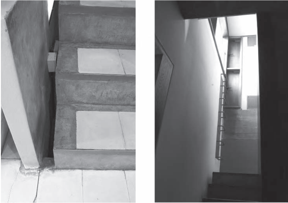
Figure 5.41 Stair Jaoul Maison B (1955)
