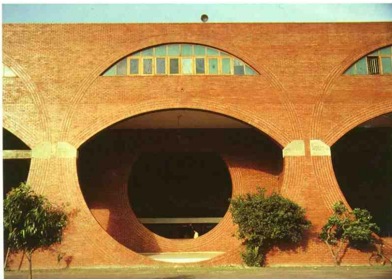
1 Escorzo de las residencias de ministros con la Asamblea al fondo. 2 y 3 Vista frontal e interior del pórtico del hospital (última foto: Shamín Javed).
