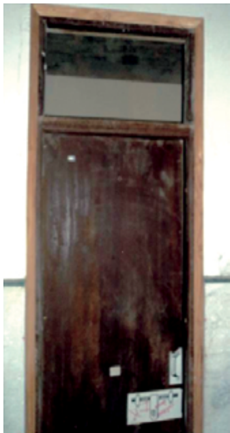
Bamboo-Jute Composite Door Doors
