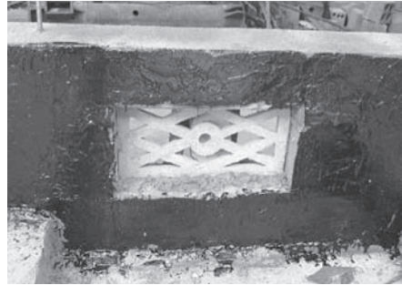
(d) Ventilation opening on cripple wall
