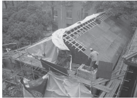
(d) Installation of roof sheathing
