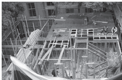
(d) Second floor joists and sheathing
